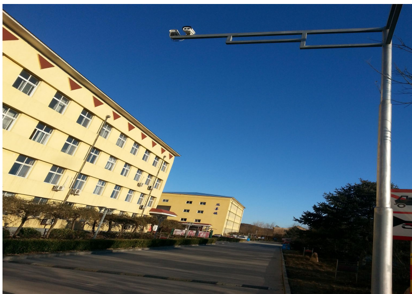
校园安防系统室外摄像头
